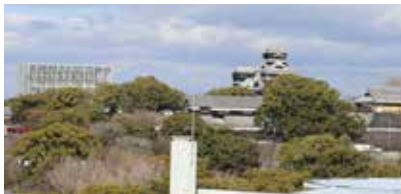
熊本城宇土櫓修復中
